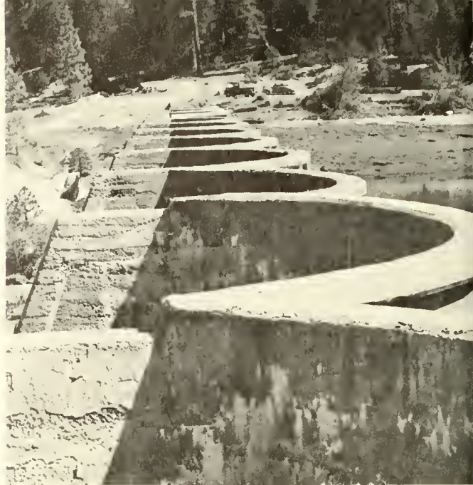
Hume Lake Dam.
